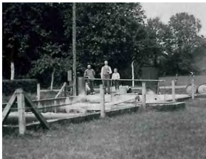
Erste Kläranlage der Firma Wiltmann 1926/27 v. l.: Fritz Loth (Hofarbeiter), Ingenieur Loof (Berater aus Hildesheim), Günter Kleine.
